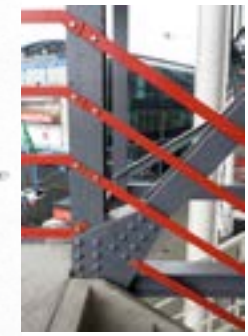
Alle trappen zijn in principe oorspronkelijk maar het beton en de hekwerken ervan zijn in 1994 vernieuwd 'naar oorspronkelijk model', de draagconstructie is nog gaaf.
